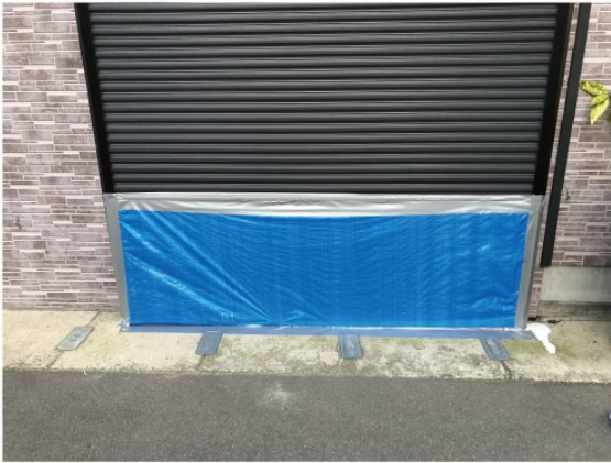
テープ貼り完了写真
